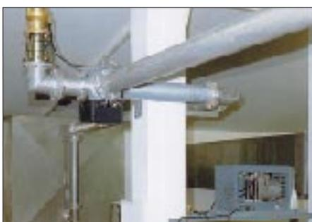
Bild 7: Umschalter für Antenne/Kunstantenne, unten rechts der Kompressor für die permanente Trockenluft-Spülung der Koaxialleitung
