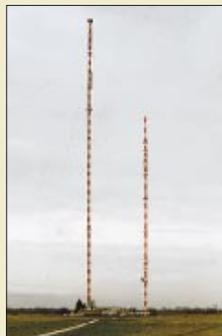
Zwei Antennenträger für UKW von 236 (links) bzw. 212 m Höhe
